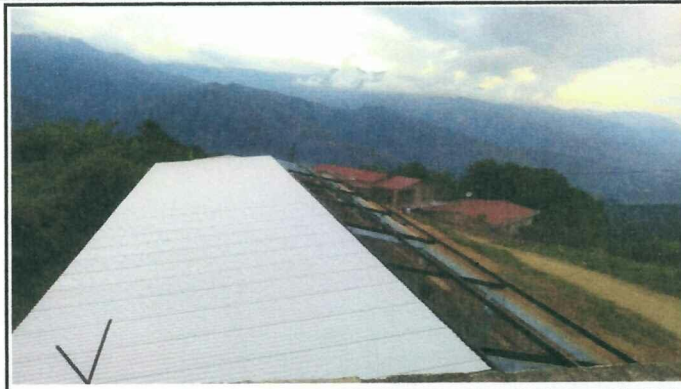
Foto 2: SUSTITUCION DE ESTRUCTURA DE TECHO
