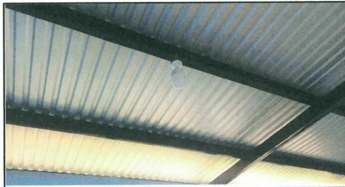
Foto 4: SUSTITUCION DE SISTEMA ELECTRICO CABLEADO CON ACCESORIOS
