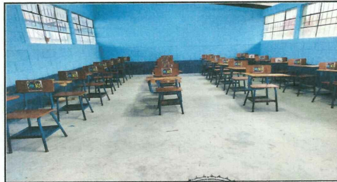
Foto 6: SUSTITUCION DE PINTURA INTERIOR Y DE VIDRIOS DE AULAS DE SEGUNDO Y QUINTO PRIMARIA
